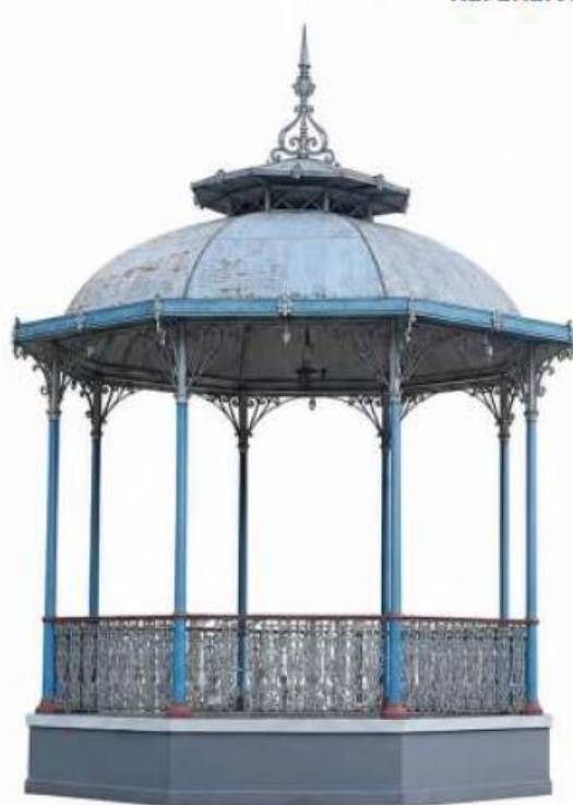
Antes da revitalização
